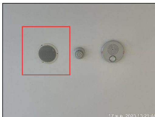
ภาพที่ 15 ลำโพงกระจายเสียงกรณีเกิดเหตุฉุกเฉิน
