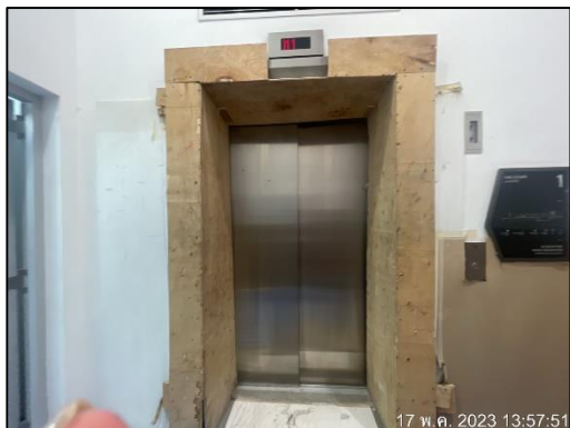
ภาพที่ 21 ลิฟต์ดับเพลิง
